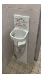
4号館1階 女子トイレ
